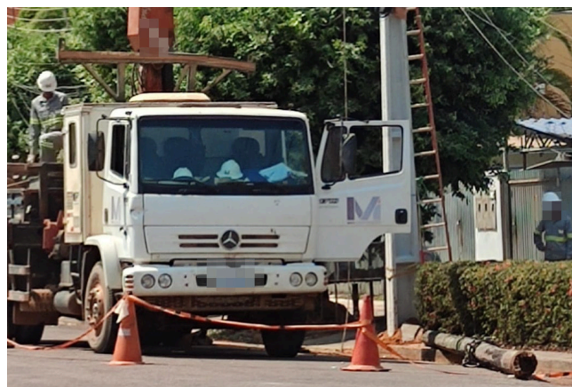
Figura 4.1: Substituição do poste de madeira por um de concreto.
